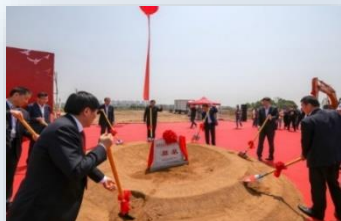
2020年4月26日 园区开工建设
